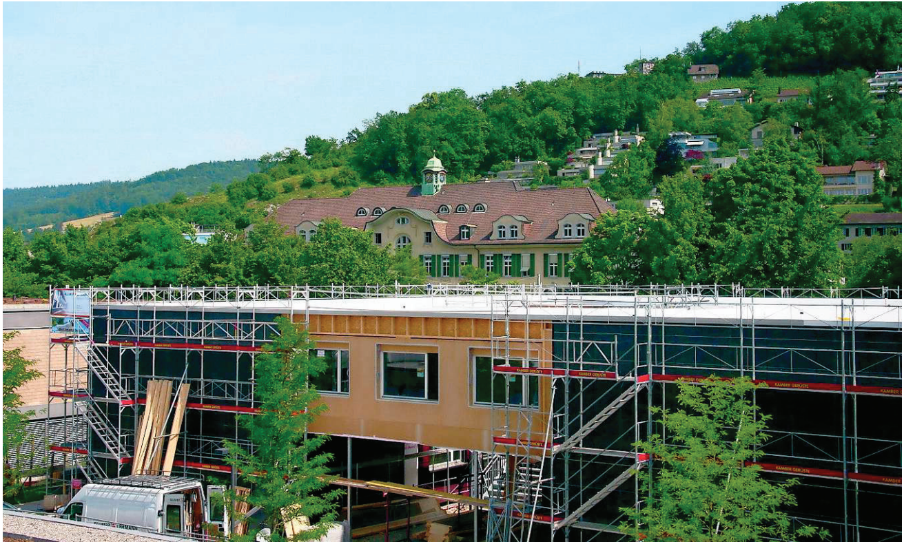
Die Kantonsschule braucht mehr Schulraum. Der Bau eines Provisoriums mit zwölf Schulzimmern ist im Gange. Mehr Platz brauche es auch für den Sportunterricht, sagt Rektor Hans Rudolf Stauffacher.
